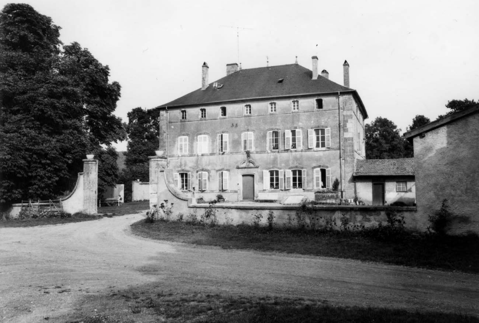
Fig. 8 Le logis abbatial, vue depuis la basse-cour.
